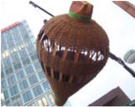
Abbau Spiegelverlagshaus Hamburg Hafencity, Roger Rigorth
